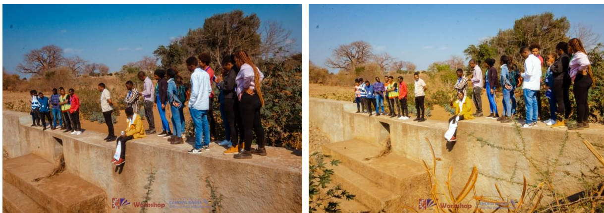
Imagem 10. Visita a barragem de Chirodze.
